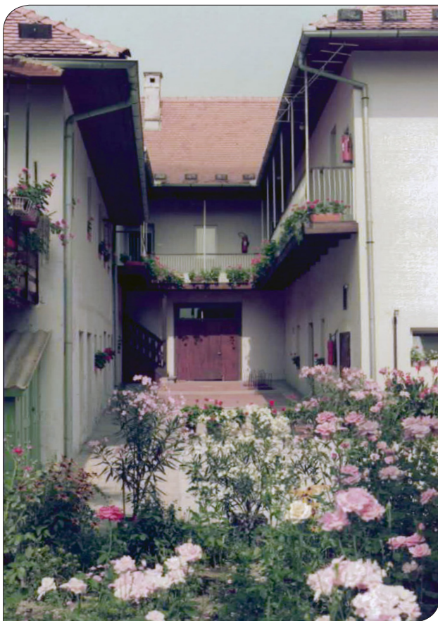
V tej stavbi na Starem trgu je glasbena šola domovala od leta 1977 do leta 2002.
